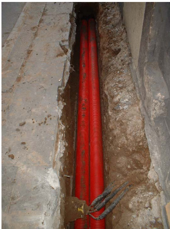
Fotografia 5: Canalitzacions dels cables elèctrics.
