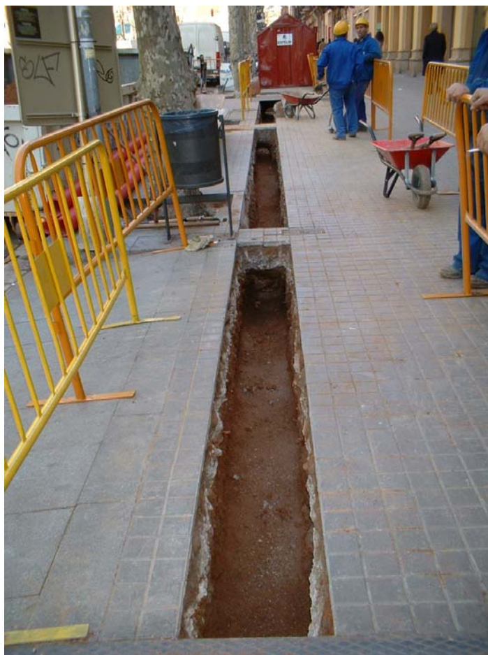
Fotografia 6: Vista general de la Rasa 200, en Ronda de Sant Antoni.
